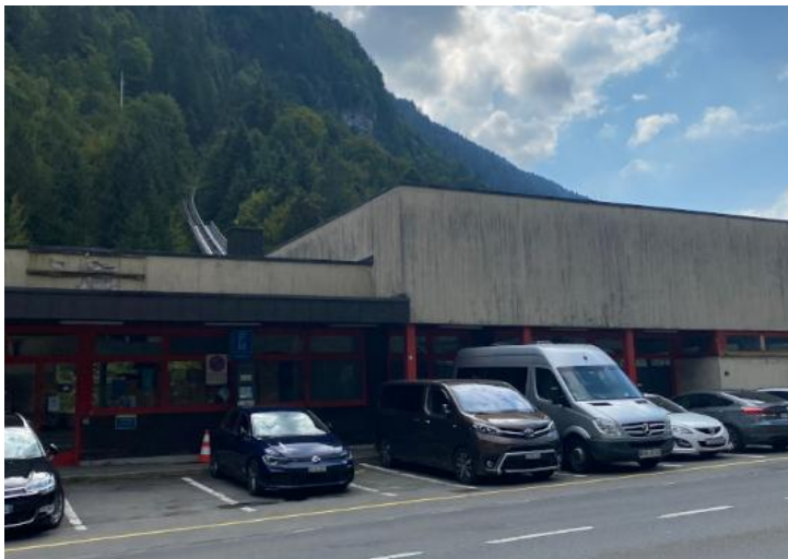
Abb. 66: Talstation der alten Stoosbahn mit Trasse im Hintergrund, 2025
