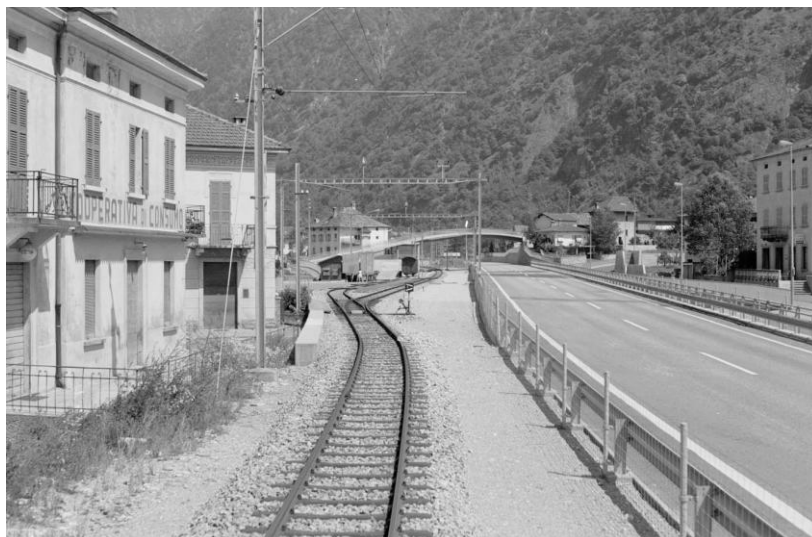
Abb. 14: BM und N13 bei Roveredo, im Hintergrund das neue Stationsgebäude
